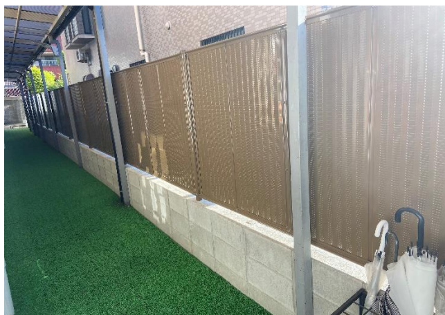
(体育館西側ブロック塀耐震改修事業)
