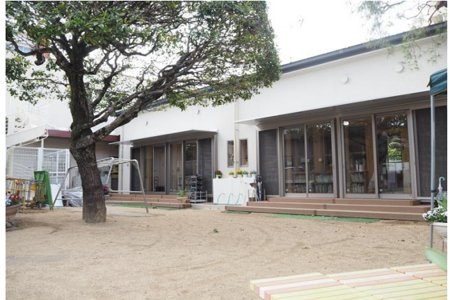
(幼稚園耐震改修工事整備事業)
