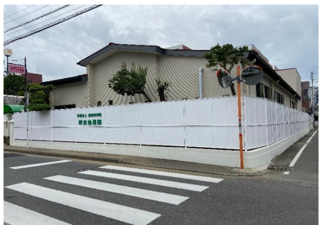
(幼稚園ブロック塀改修工事事業)
