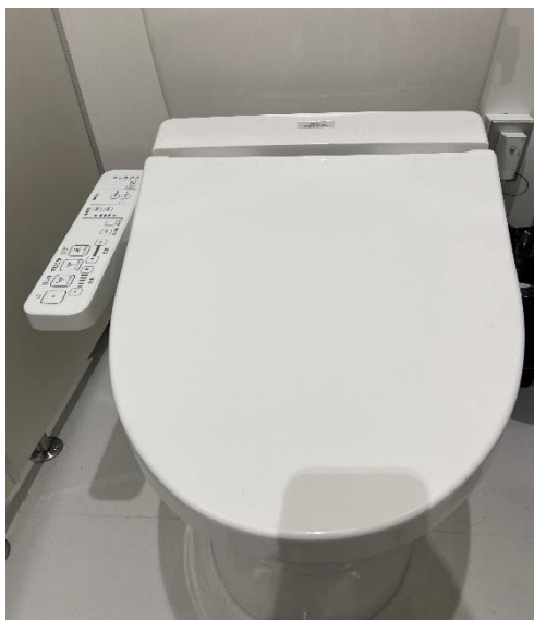
(高校便座改修工事事業)
