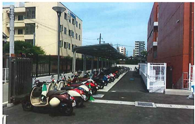
(3号館北側駐輪場)
