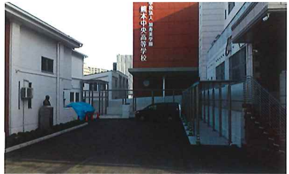
(3号館庇通路等外構工事)
