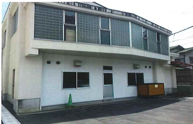
(多目的室外観 (1階))
